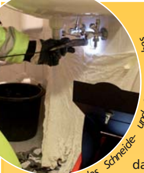
Einführung des Schneide- und Spülschlauches
